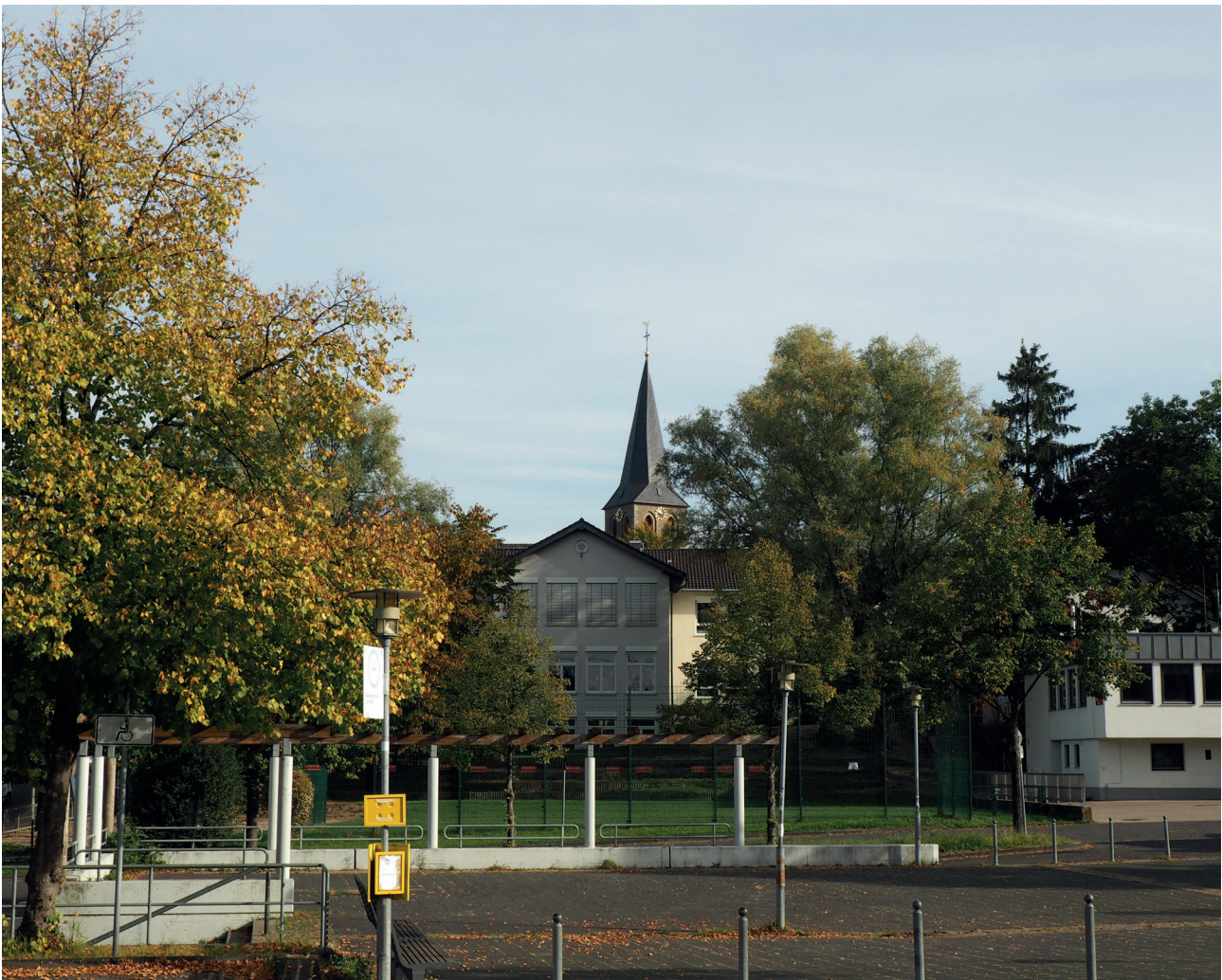
Blick ehemalige Feuerwache und ehemalige Schule
